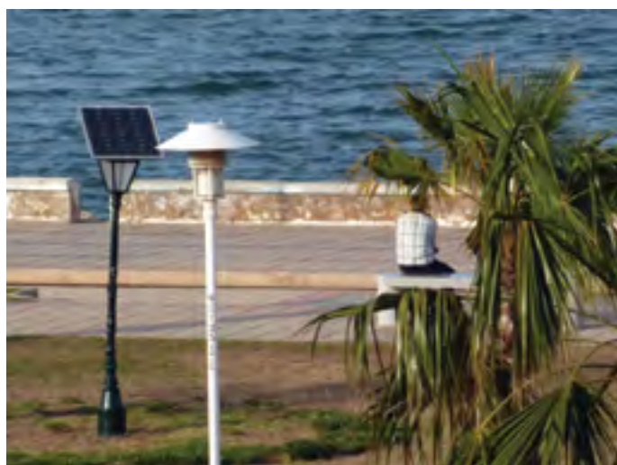
Energías renovables en el Paseo Marítimo.
