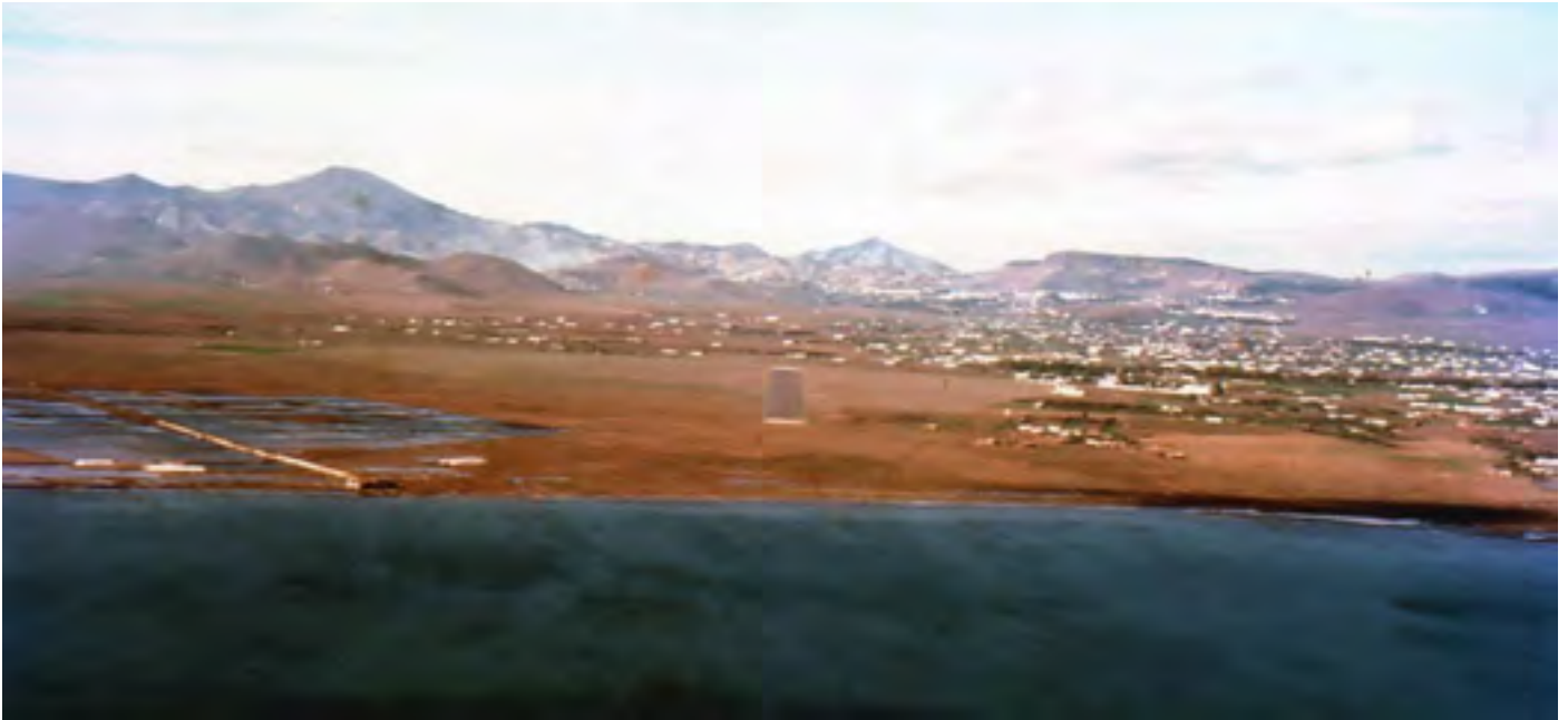
Pista principal del aeródromo de Taouima, con la Mar Chica abajo. A la parte izquierda superior de la pista se está construyendo el "nuevo Lope".
